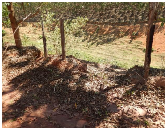
Talude sem cobertura vegetal.
