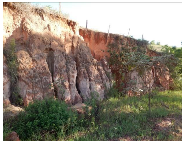
Talude de corte erodido
