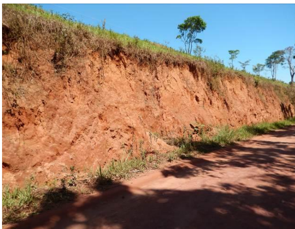
Talude sem cobertura vegetal.
