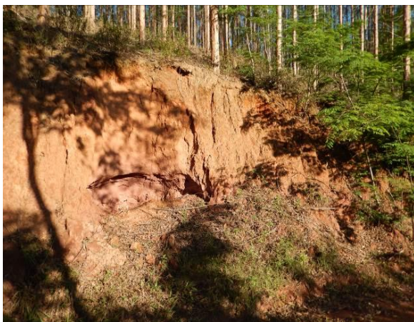
Talude de corte erodido
