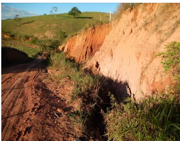
Talude de corte erodido
