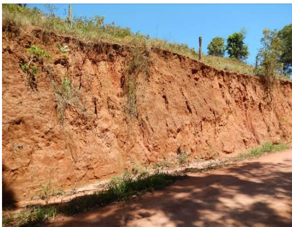
Talude de corte com focos erosivos.
