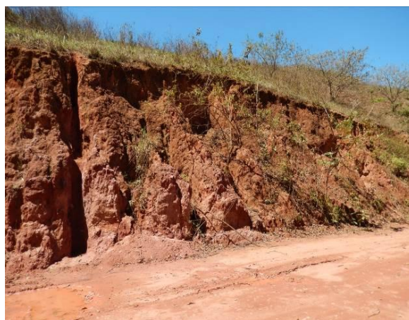
Talude de corte sem cobertura vegetal e com focos erosivos.
