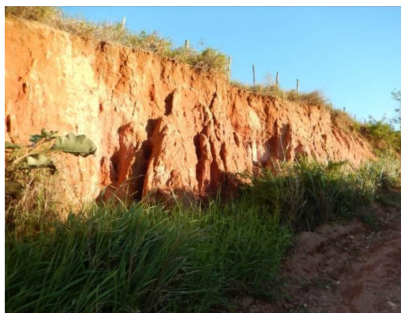
Talude de corte erodido
