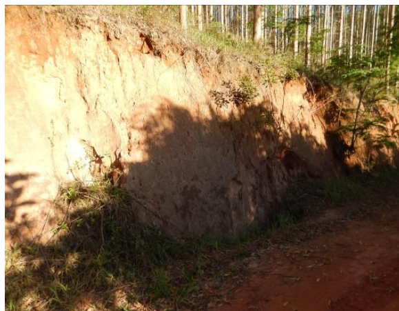
Talude de corte erodido
