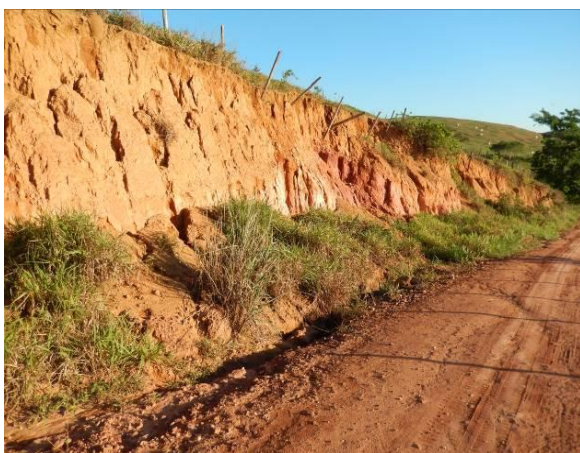
Talude de corte erodido
