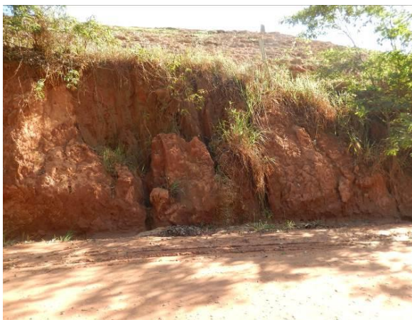
Talude de corte erodido.
