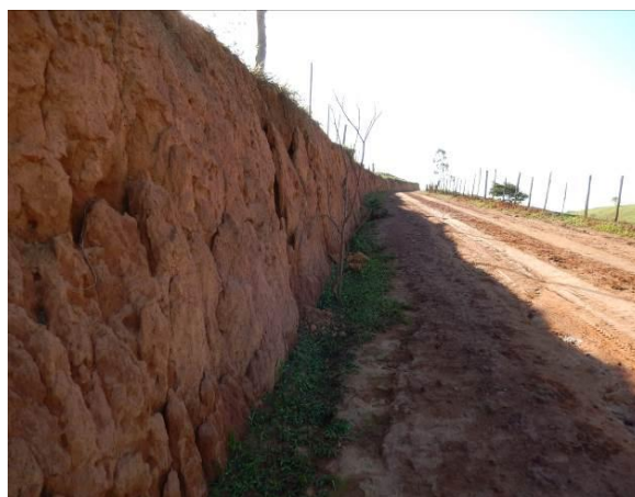
Erosão no bordo da plataforma.
