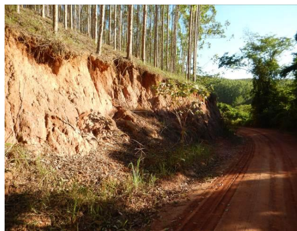
Talude de corte erodido
