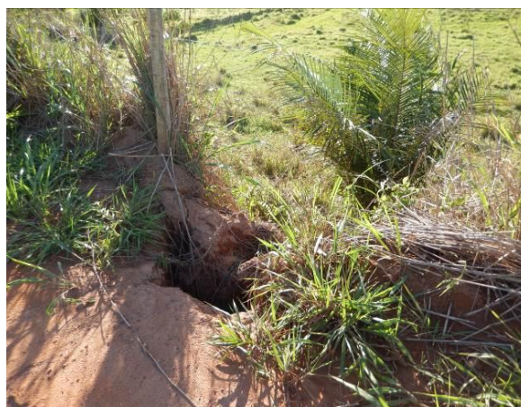
Talude de aterro erodido.
