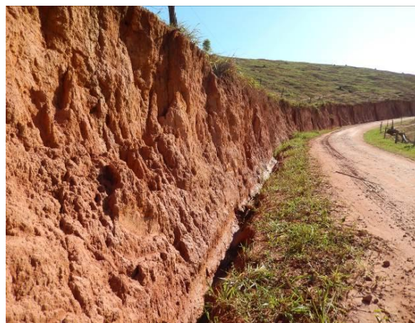
Erosão no bordo da pista e talude erodido.
