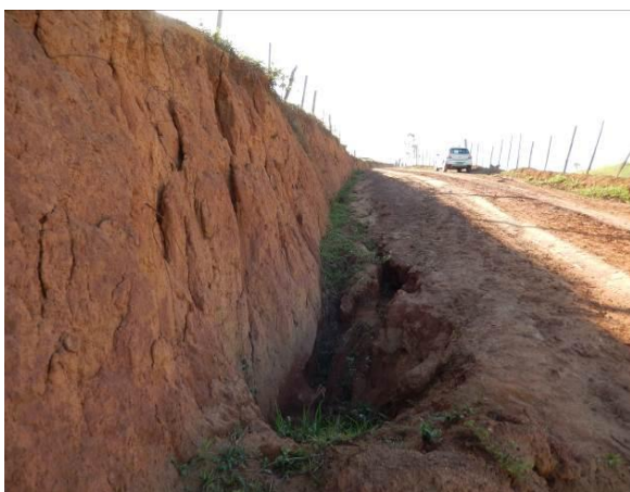
Erosão no bordo da plataforma.
