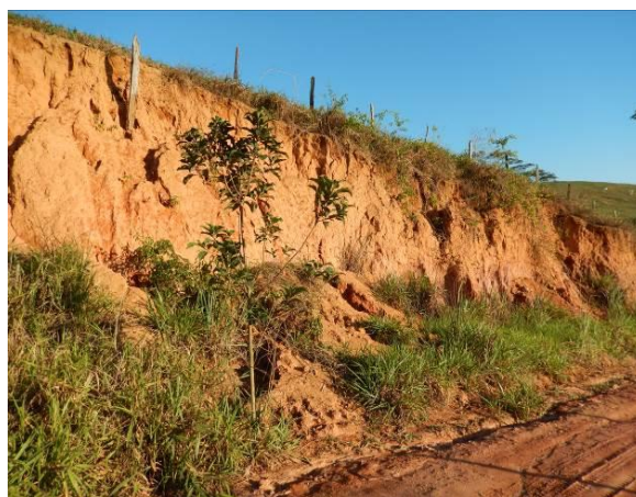
Talude de corte erodido
