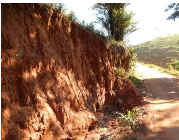
Talude de corte erodido
