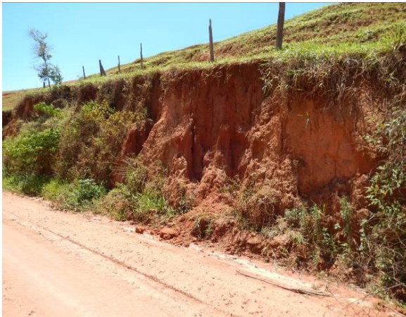
Talude de corte erodido
