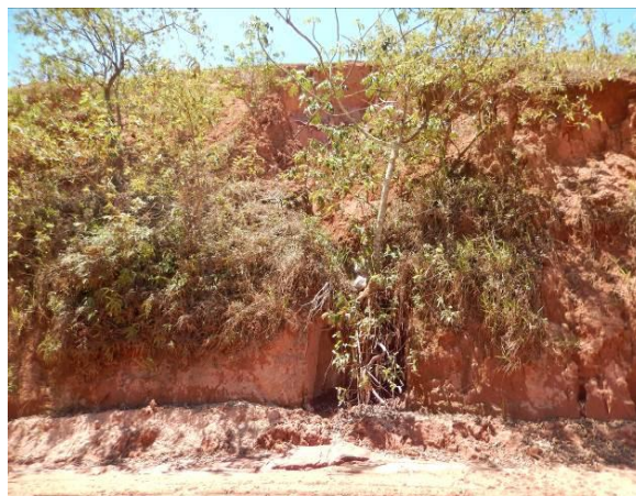
Talude de corte erodido
