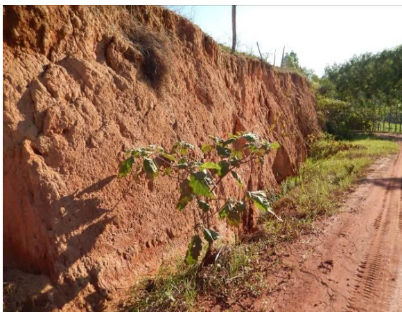
Talude de corte erodido
