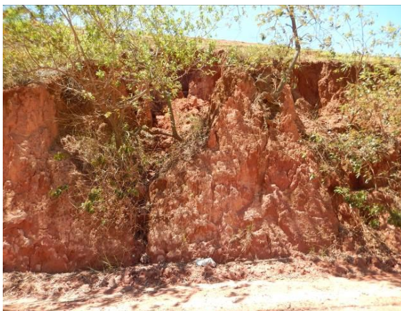
Talude de corte erodido
