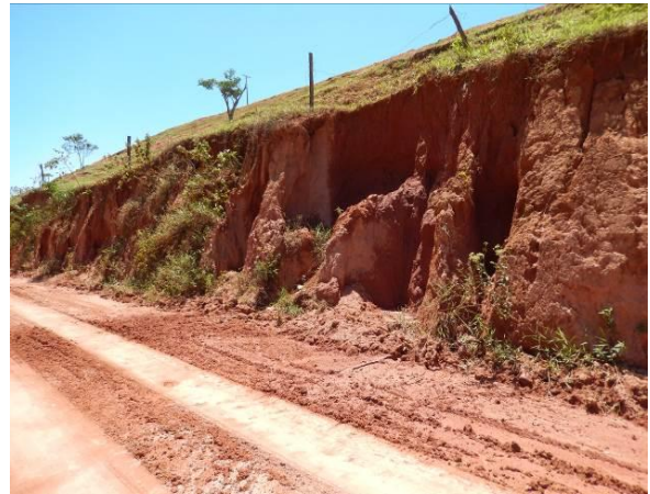
Talude de corte erodido
