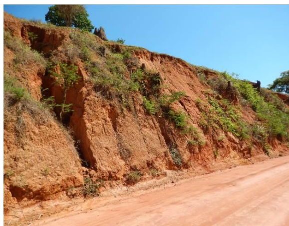
Erosão no talude de corte.
