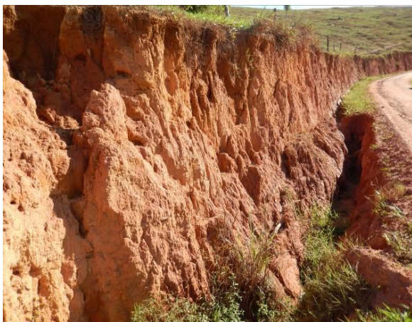
Erosão no bordo da pista e talude erodido.
