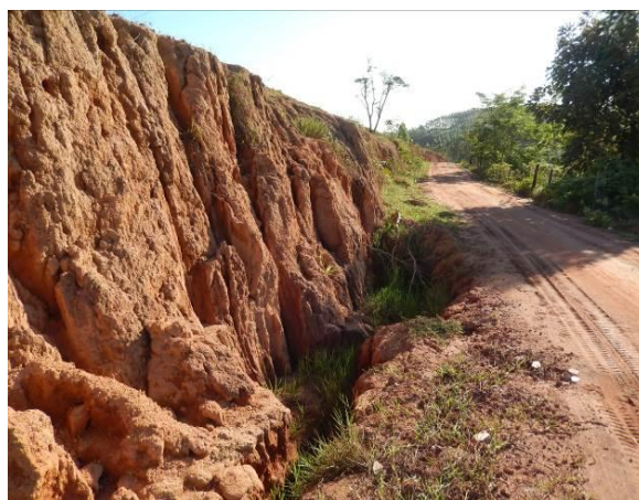
Talude de corte erodido
