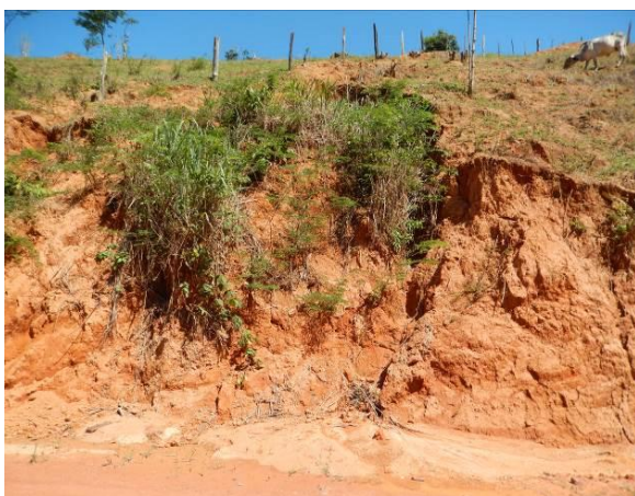
Erosão no talude de corte.
