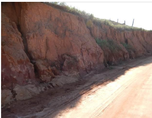
Talude de corte erodido.
