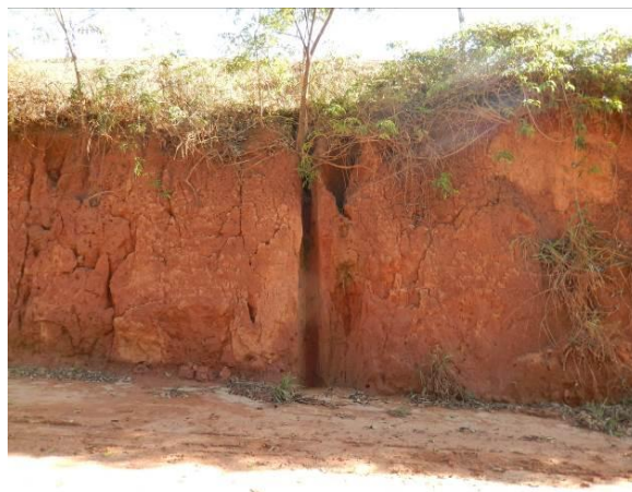
Talude de corte erodido.
