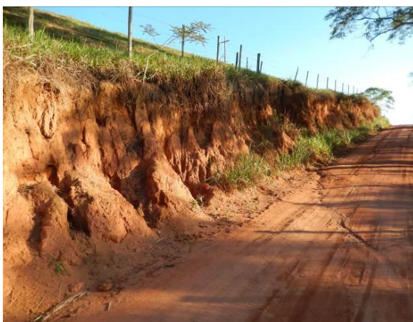
Talude de corte erodido
