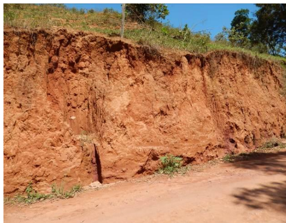
Talude de corte com focos erosivos.
