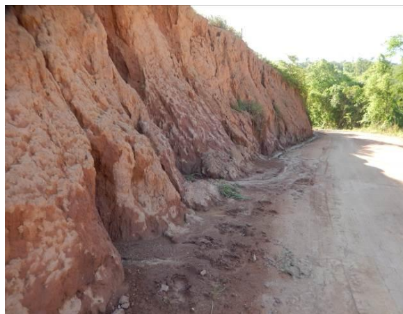
Talude de corte erodido.
