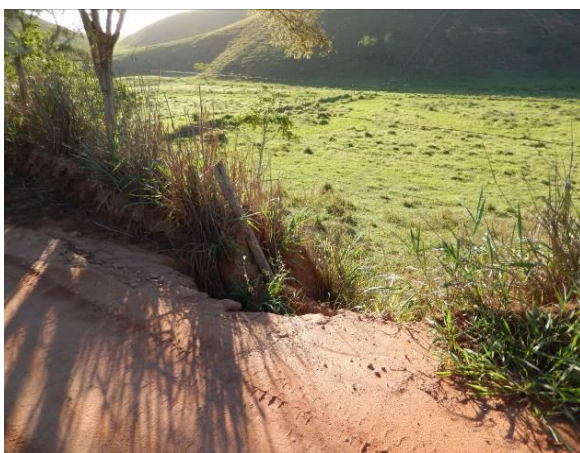
Talude de aterro erodido.
