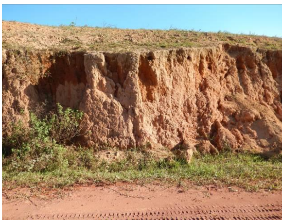
Talude de corte erodido
