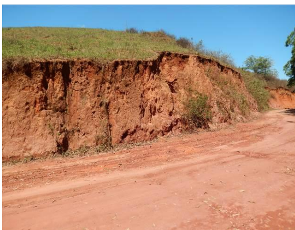
Talude de corte sem cobertura vegetal e com focos erosivos.
