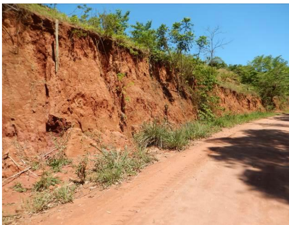
Talude de corte sem cobertura vegetal.
