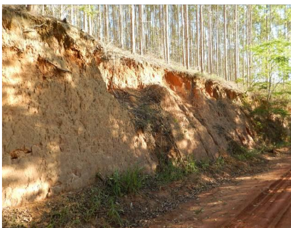
Talude de corte erodido
