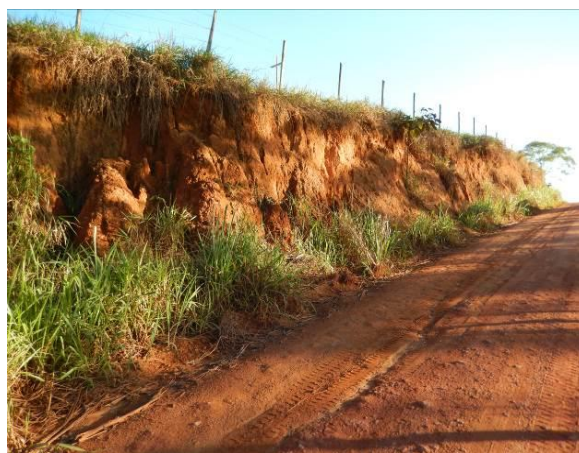
Talude de corte erodido
