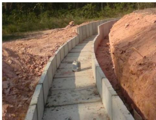
CANALETA DE PROTEÇÃO DE TALUDES.
