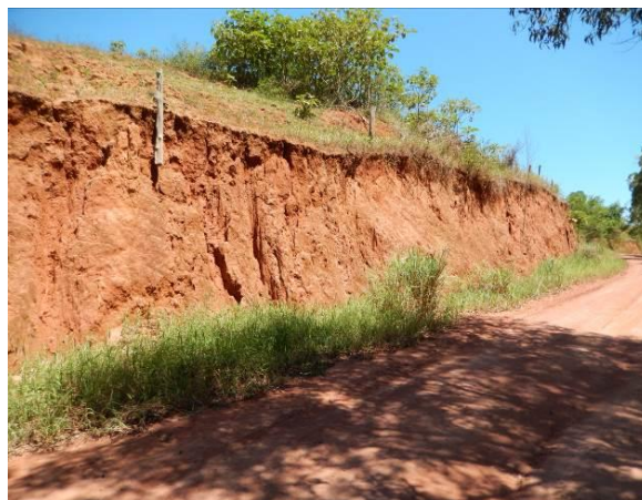
Talude de corte sem cobertura vegetal.
