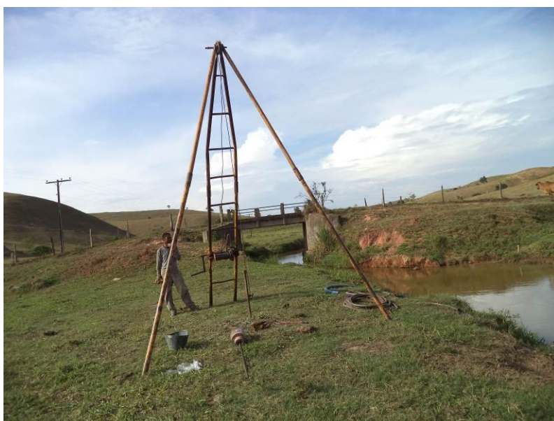
Instalação do furo SP02 Lado Esquerdo
