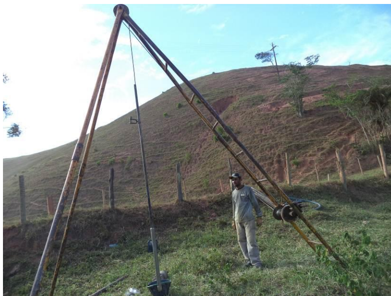
Instalação do furo SP02 Lado Esquerdo
