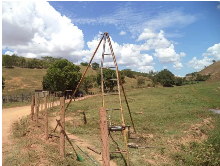
Instalação do furo SP01 Lado Direito
