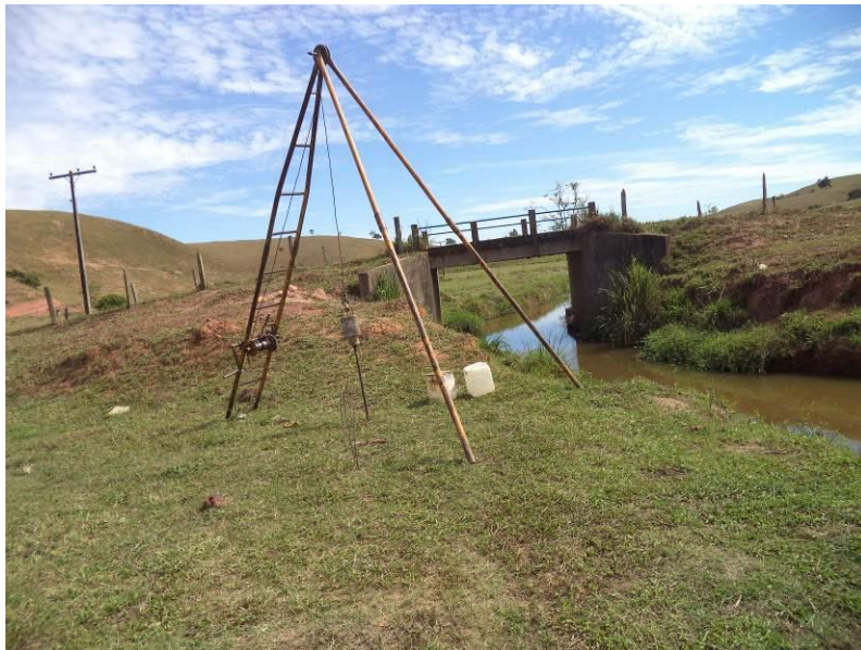
Instalação do furo SP01 Lado Direito
