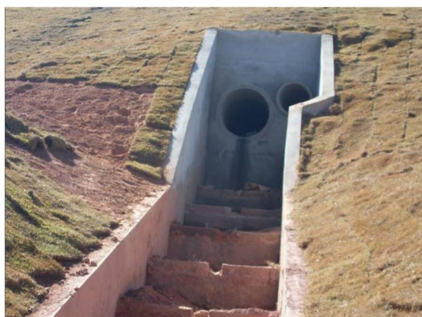
ESCADA D'ÁGUA OU DISSIPADORES DE ENERGIA.
