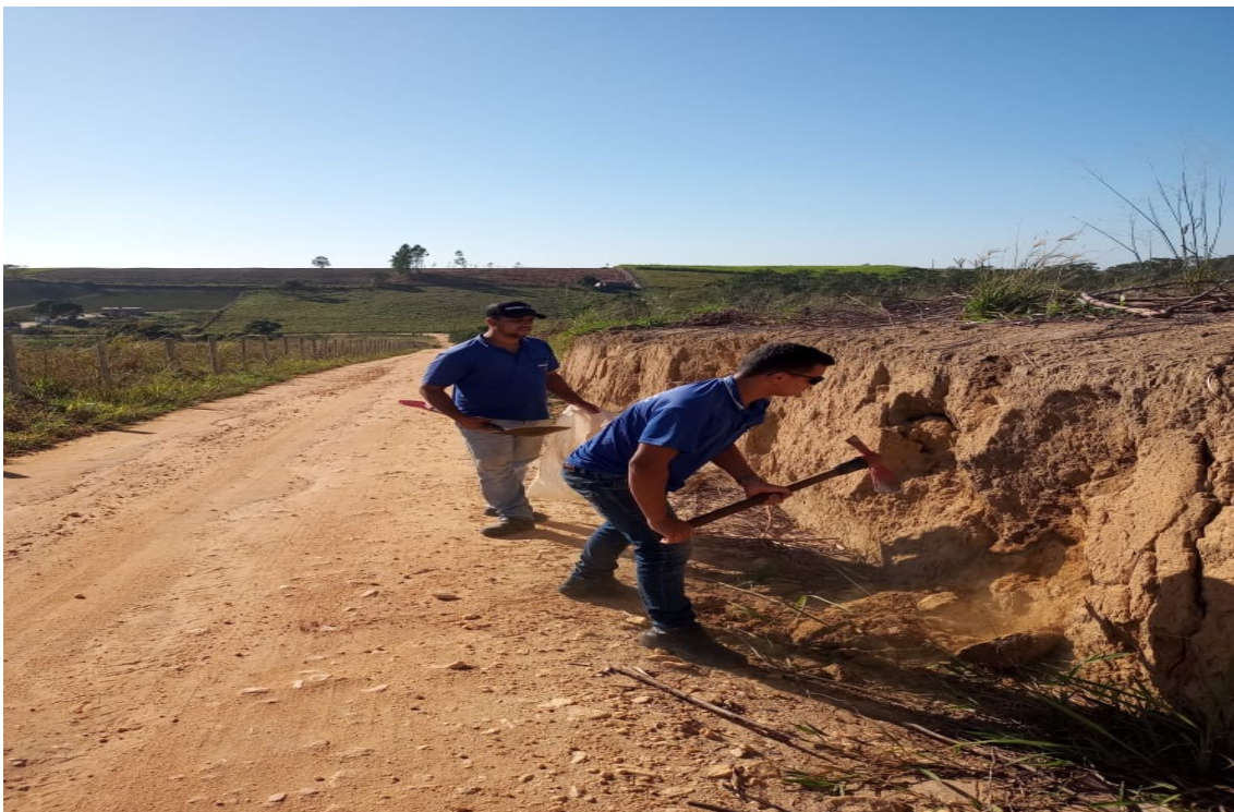
Coleta de amostra do sub leito, estaca 149 a 158
