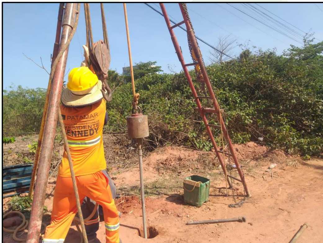
Execução de sondagem SPT
