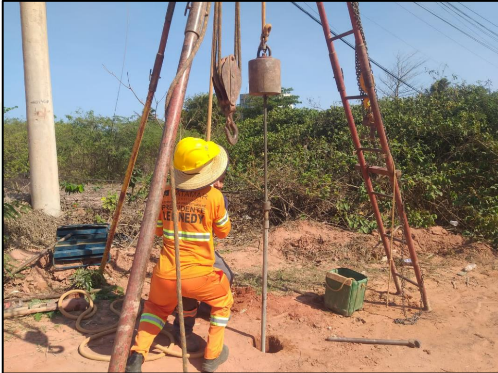
Execução de sondagem SPT
