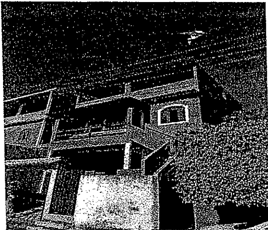
Fachada do imóvel, 1º pavimento.
