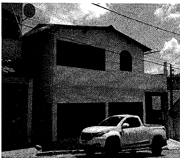
Fachada do imóvel pavimento térreo.
