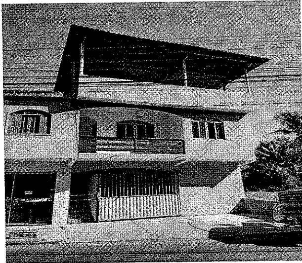
Fachada do imóvel, 1º e 2º Pavimento.
