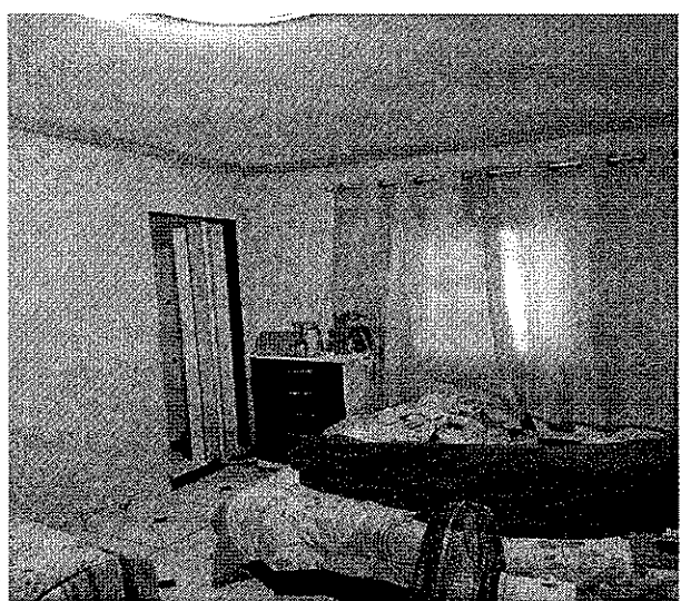
Quarto 02 com rebaixamento em gesso.
