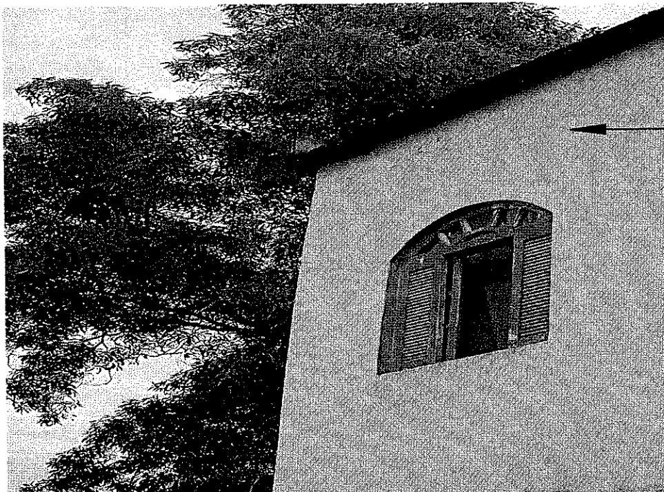
Trinca na parede externa.
