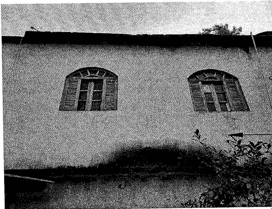
Área de serviço com trinca na parede.
