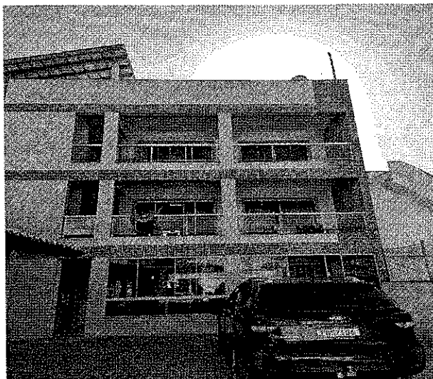
Fachada do imóvel, 1º Pavimento.
