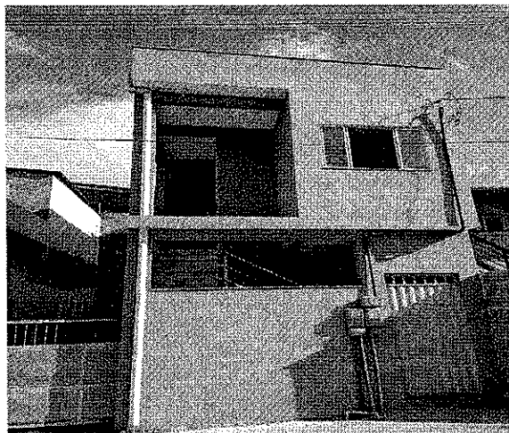
Fachada do imóvel, pavimento térreo.
