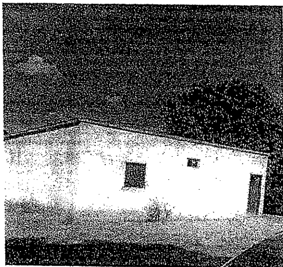
Fachada do imóvel pavimento térreo.
