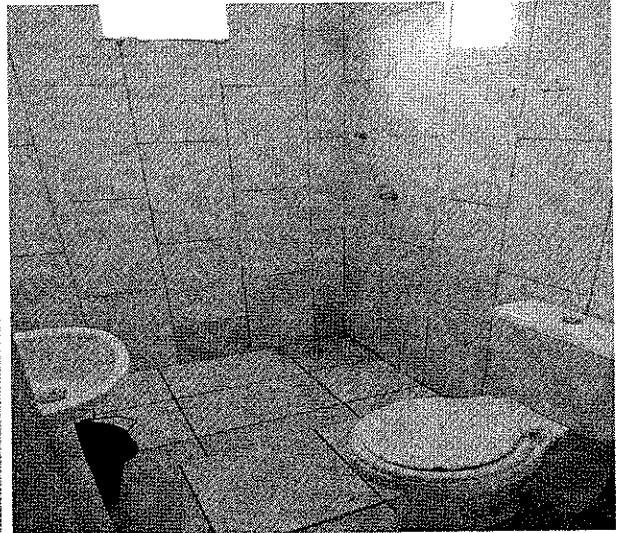
Banheiro 02 com revestimento cerâmico até ao teto.
