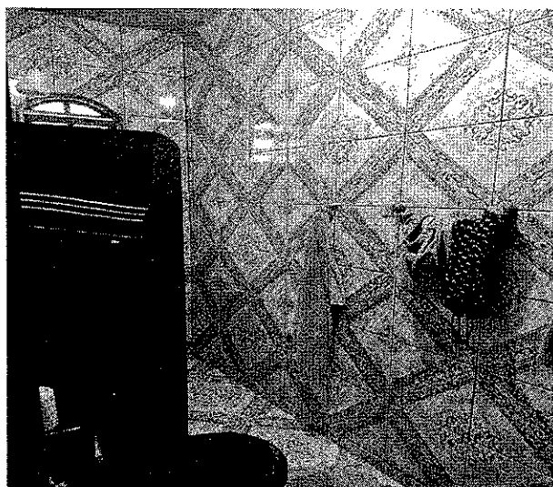
Figura 7: Banheiro com revestimento cerâmico até ao teto.
