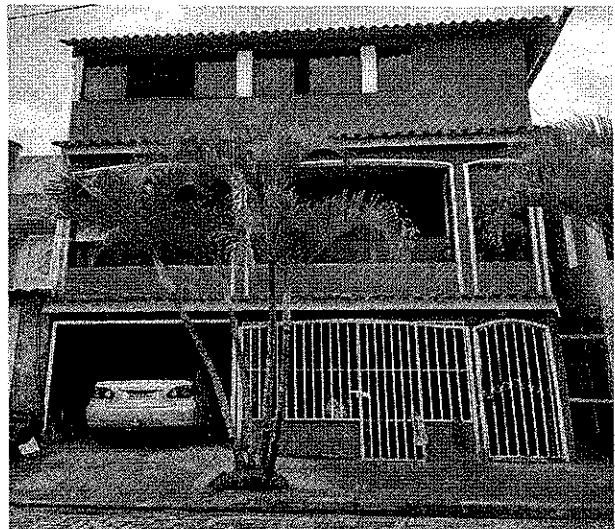
Figura 1: Fachada frontal, imóvel localizado no 1º e 2º pavimento.
