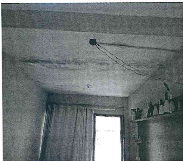
Sala com trinca no teto; Banheiro com louças sanitárias e revestimento cerâmico até o teto.
