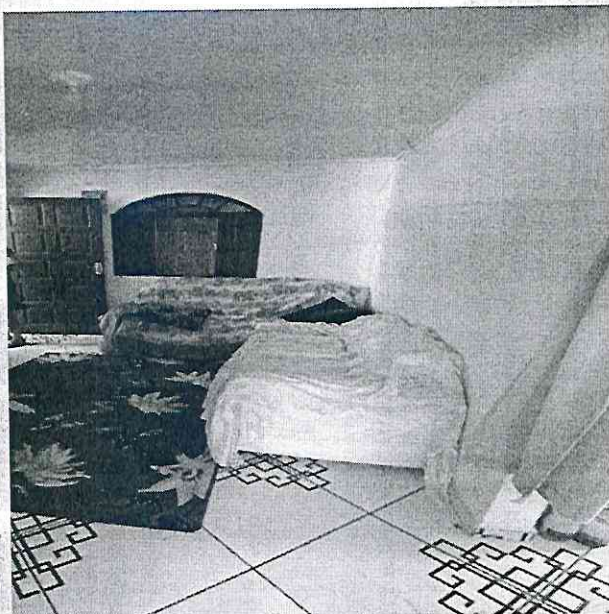
Sala com rebaixamento do teto em forro PVC.
