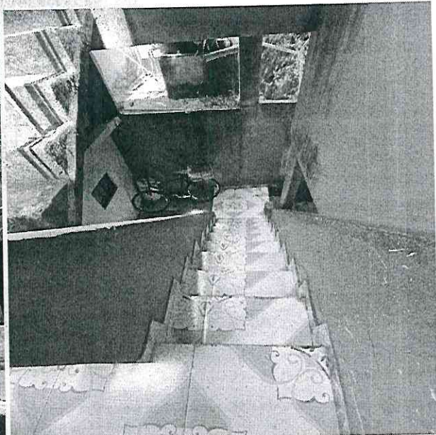
Escada de acesso ao 1º pavimento.
