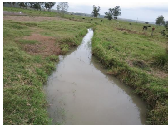
Figura 24 - Vista parcial do Valão São Paulo
