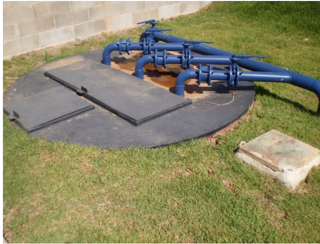
Figura 2 – Modelo de Estação Elevatória de Esgoto (EEE).
